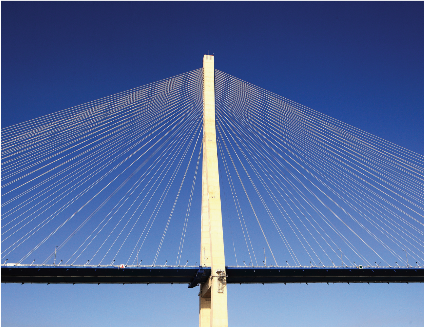
왼쪽 덤플이 설치된 케이블 표면, 오른쪽 대칭을 이룬 케이블 배열
